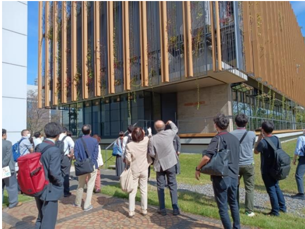
グリーンオフィス棟
